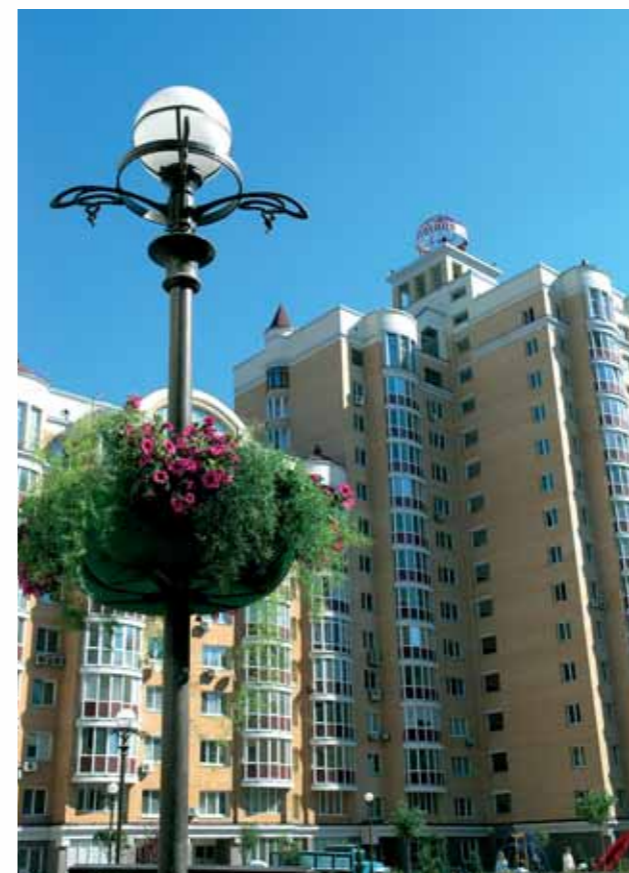
Фрагмент забудови 3-А мікрорайону “Оазис”
