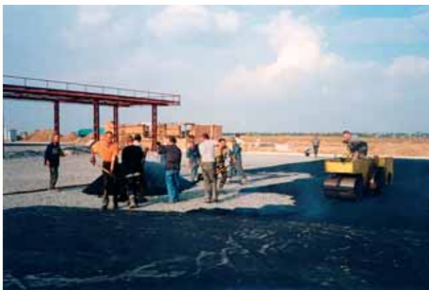
Будівництво автомобільної газонаповнювальної компресорної станції (АГНКС) у м. Вінниця
