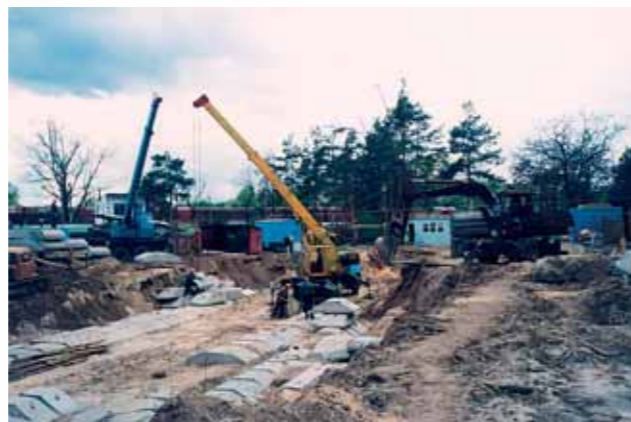
Будівництво 67-квартирного житлового будинку в смт Коцюбинське Київської області
